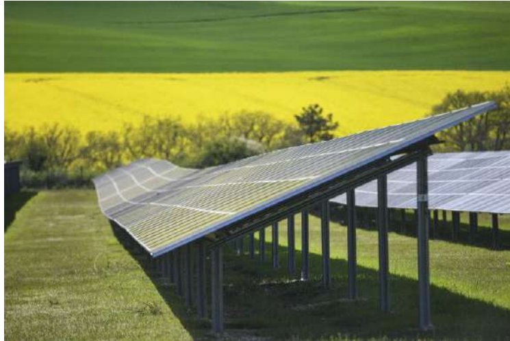
Figure 6 : Panneaux sur structure gabion
